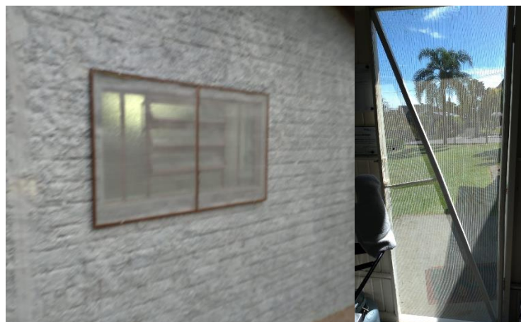
Figura 6: Aberturas com tela milimétrica. Fonte: O autor, 2022.
