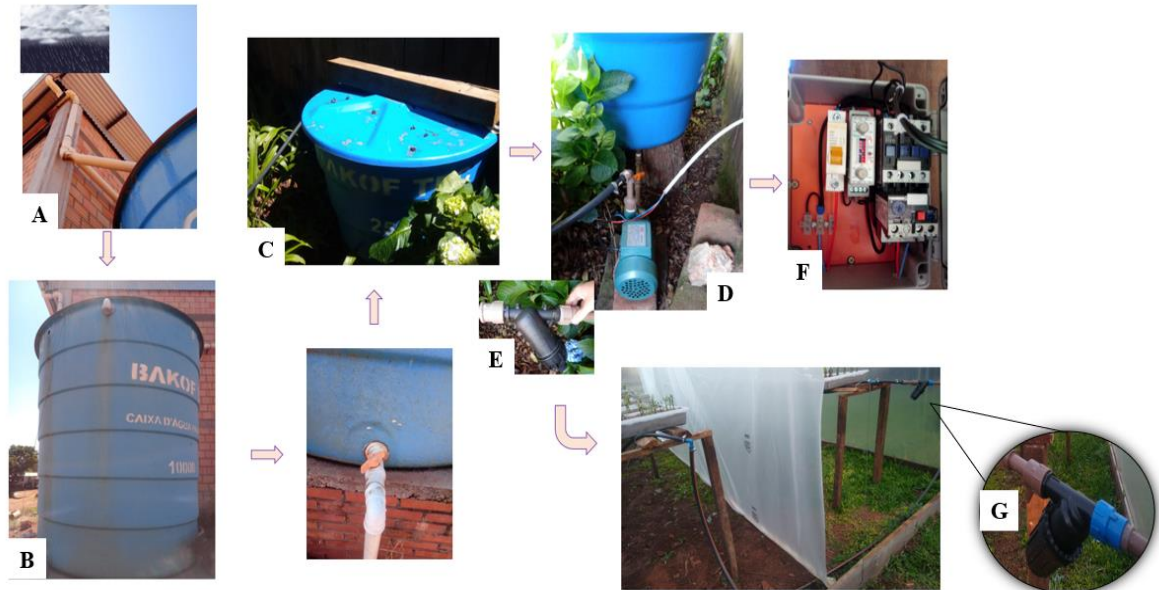
A: calhas coletoras de água B: caixa d'água coletora (10.000 L) C: caixa d'água armazenadora (250 L) D: bombeamento de água E: filtro de discos F: timer G: clorofácil
