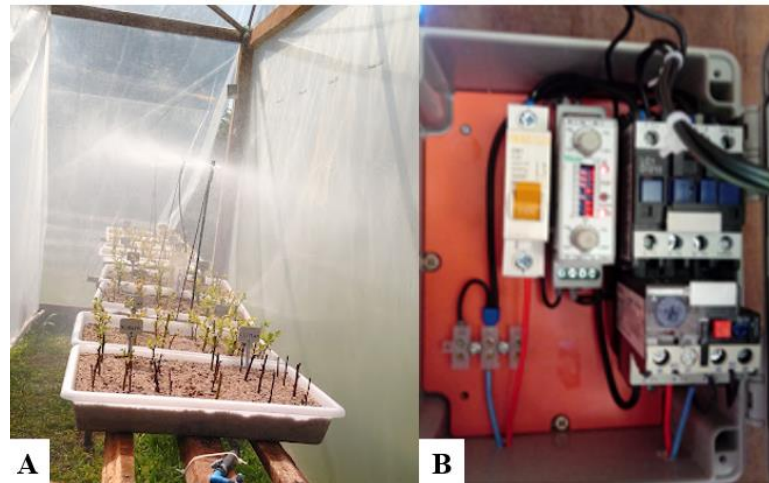
A: irrigação por nebulização B: timer programado
