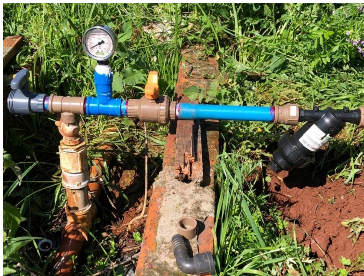
Figura 10 - Manômetro e filtro de disco do sistema de irrigação.
