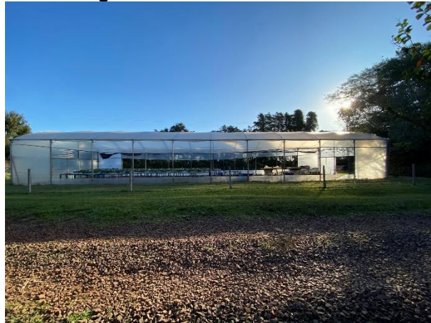
Figura 1 - Vista lateral da estufa.
