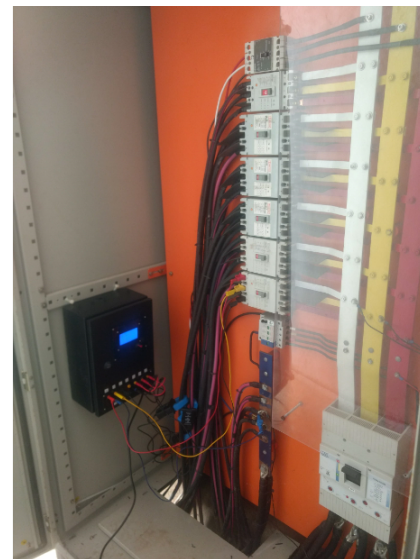
Figura 18: Instalação no QGBT
