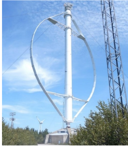
Figura 4 – Aerogerador tipo Darrieus
