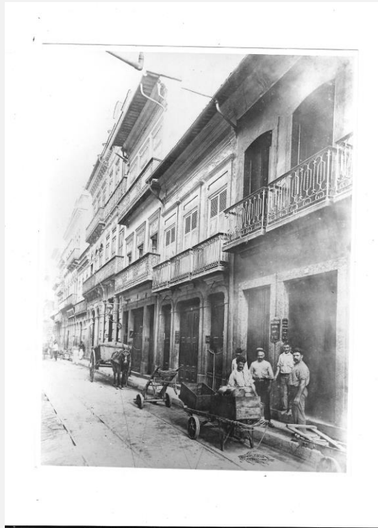
Fotografia 4 – “Carregadores e casas marcadas para desapropriação”.
