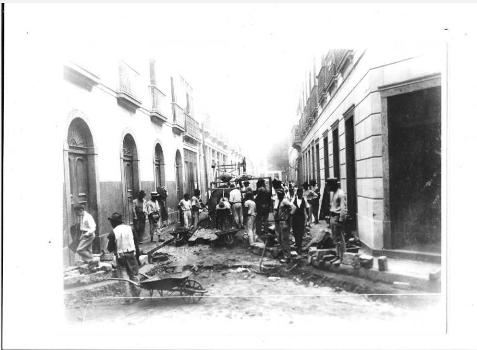
Fotografia 17 - "Obra de calçamento da Rua da Alfândega".
