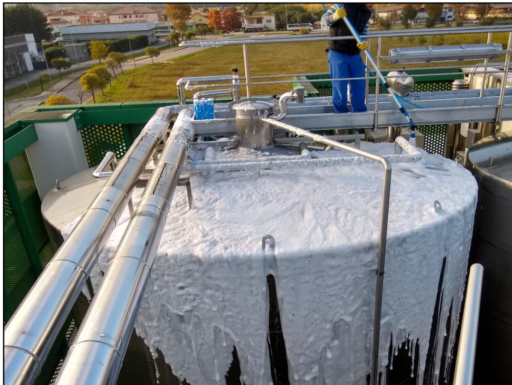
Figura 21: Limpeza externa de tanques externos de Ce. Vi. V de Sussegana. Fonte: Diego Piccoli ( Ce.Vi.V Sussegana IT 2018).
