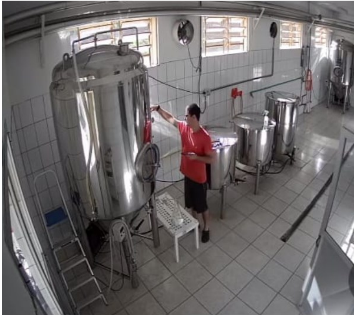
Figura 23: Tanque de fermentação
