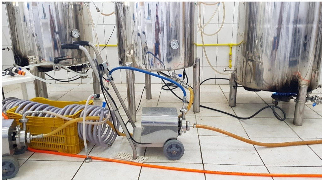
Figura 22: Trocador de calor de mangueiras
