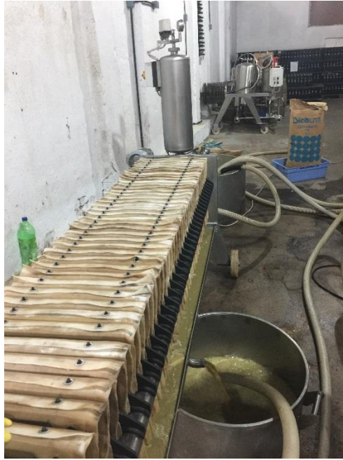
Figura 4 Filtro a placas
