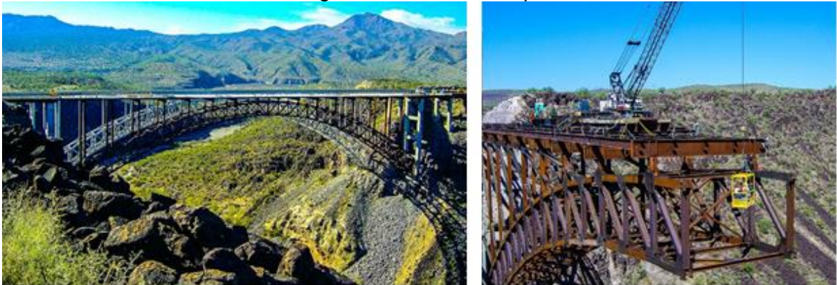
Figura 7 – Em (a) Burro Creek Bridge sobre o cânion e em (b) processo de montagem da estrutura da ponte.
