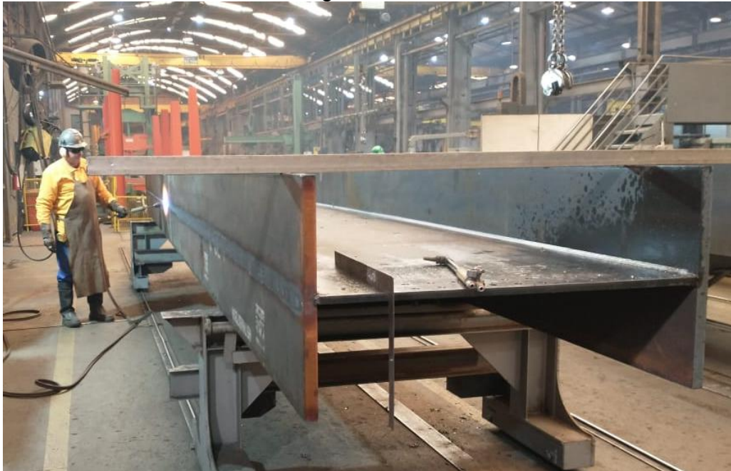
Figura 19 – Desempeno manual por chama para correção de distorção angular em uma viga “I” estrutural.
