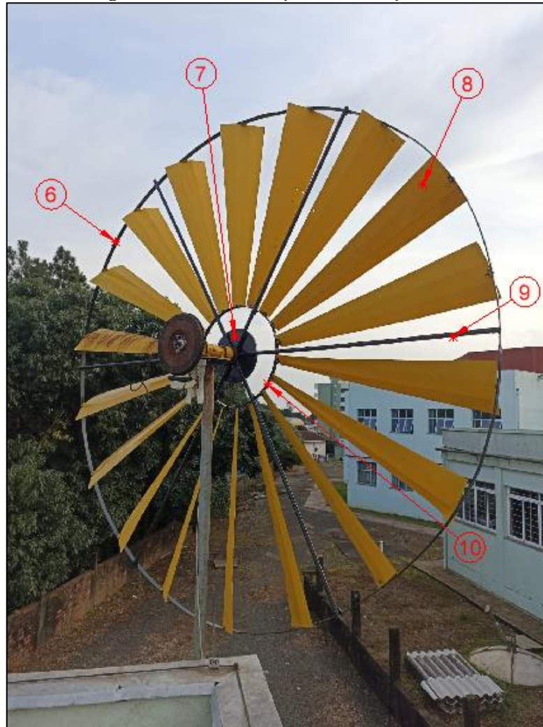
Figura 19 - Turbina multipás e seus componentes
