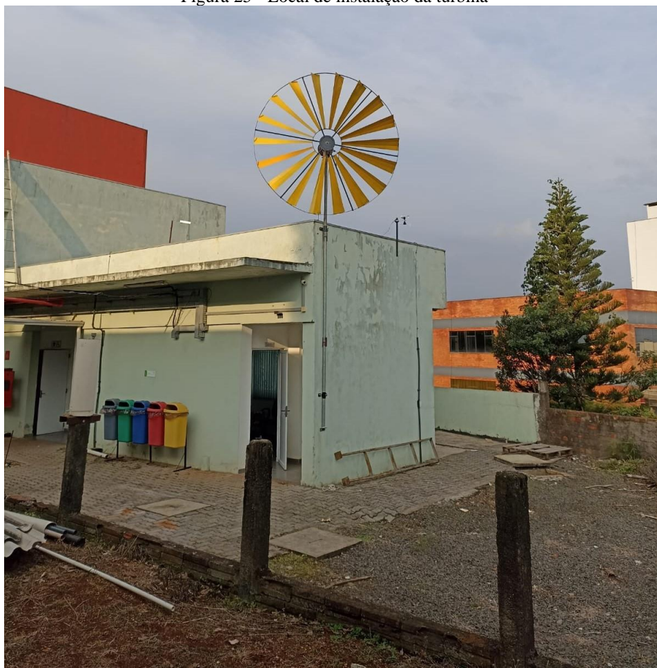
Figura 25 - Local de instalação da turbina
