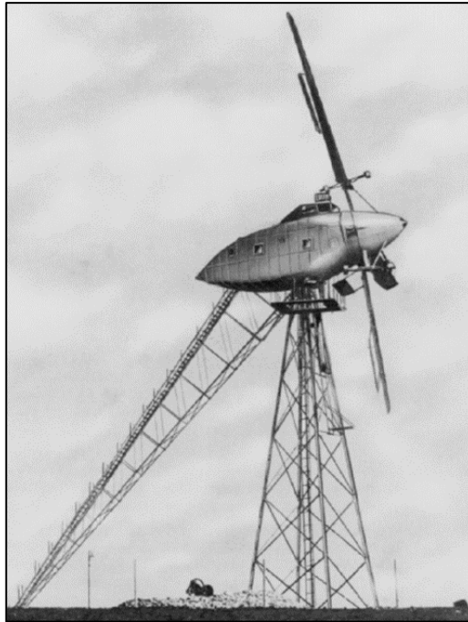
Figura 5 - Turbina eólica construída na Rússia
