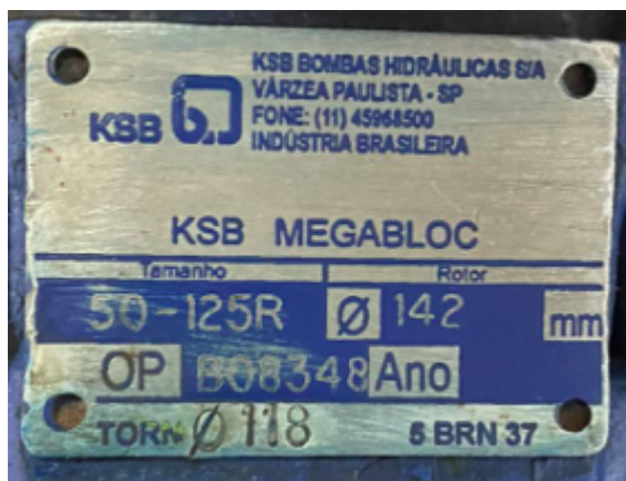
Figura 33 - Modelo bombas de água gelada.
