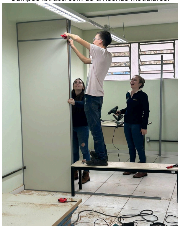
Figura 3 – Construção da sala de crescimento do Laboratório de Propagação Vegetal do IFRS Campus Ibirubá com as divisórias modulares.
