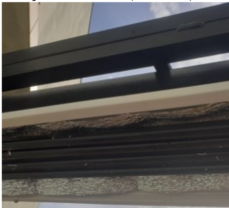
Figura 21: Tubos do trocador pintados na cor preta.
