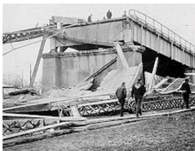
Figura 1. Ponte U.S. 35 Silver Bridge Oeste de Virginia (1967). Fonte: (Schajer, 2018)
