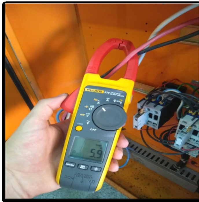
Figura 8: Medição da corrente consumida pelo motor trifásico com alicate amperímetro.
