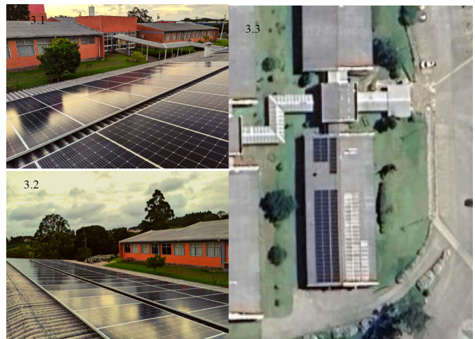
Figura 2. Sistema FV de 55,4kWp IFRS Campus Farroupilha, Fonte: 3.1 e 3.2 Site do IFRS 2021, 3.3 Google Maps 2024
