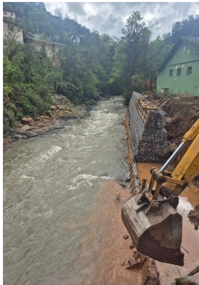
Figura 8. Obra de contenção
