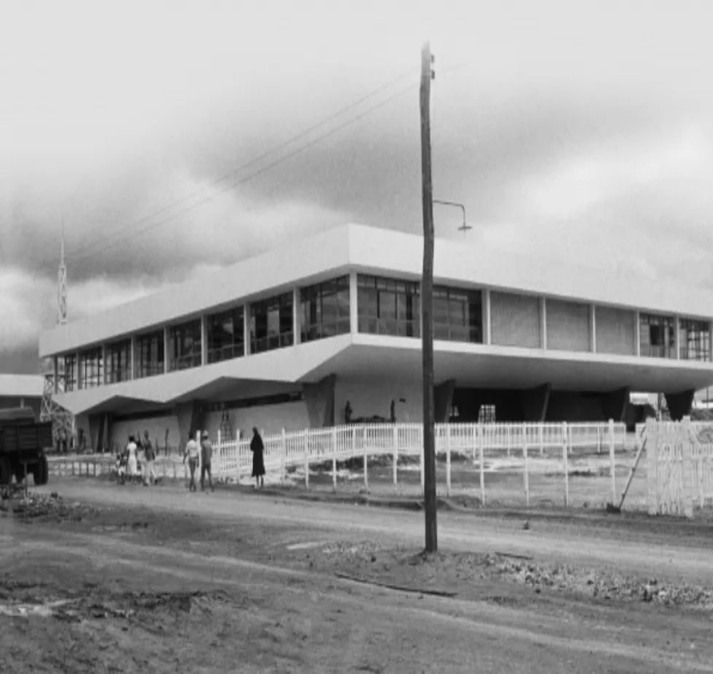
Escola Parque 308 Sul, em Brasília, durante construção, em 1960 — Foto: Reprodução/Inep
