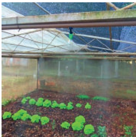
Figura 1: Montagem do sistema de irrigação via nebulização.
