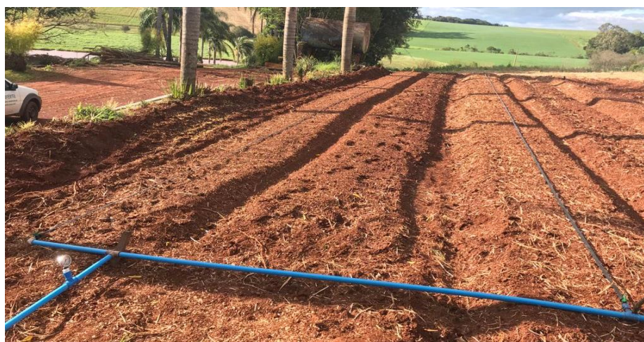
Figura 6- Visualização da linha principal e linhas laterais em sistema de irrigação por gotejamento
