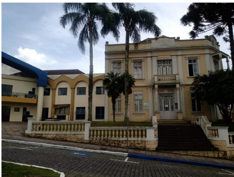
Figura 1. Fachada da Prefeitura Municipal de Garibaldi.
