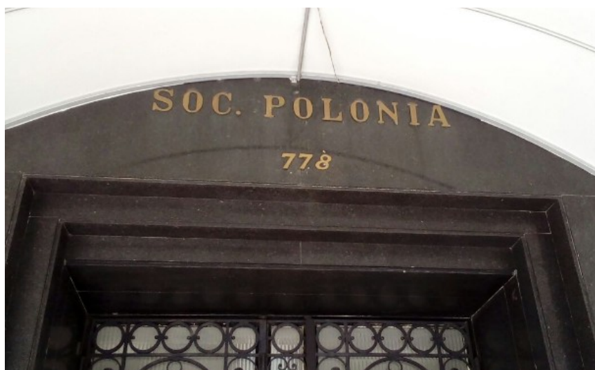
Figura 2 – Frente do prédio
