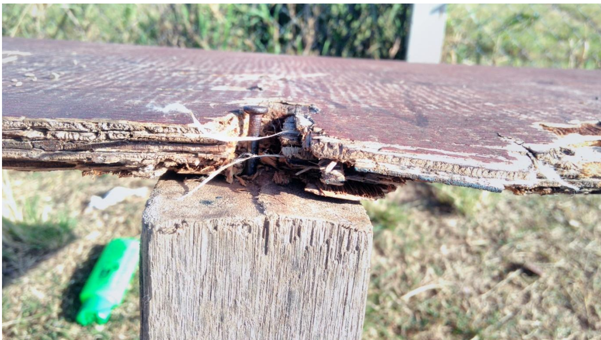
Figura 22 - Banco Seis, detalhe
