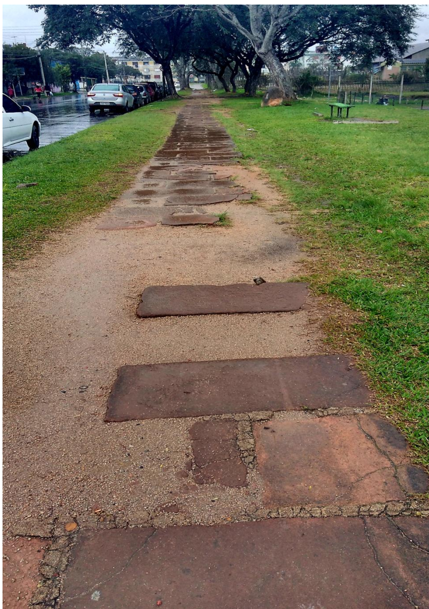
Figura 11 - Onde há calçamento no espaço (Av. Macedônia)
