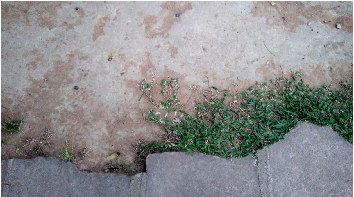
Figura 12 - Detalhe do calçamento
