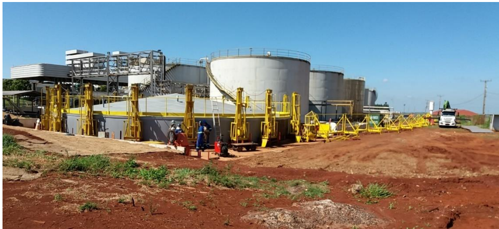
Figura 16 – Montagem com o auxílio de macacos hidráulicos
