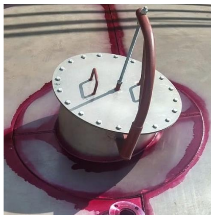
Figura 14 – Porta de inspeção no teto
