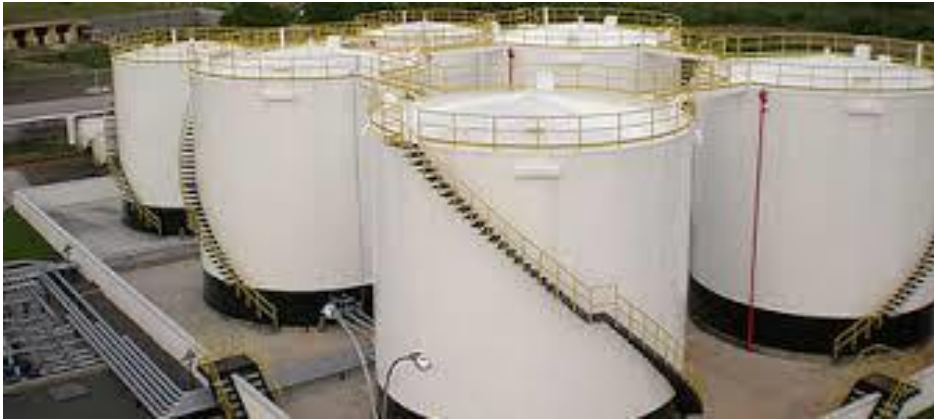
Figura 2 – Modelo de tanque com teto fixo
