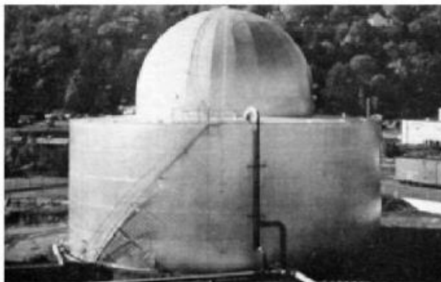
Figura 3 – Modelo de tanque com teto de diafragma flexível
