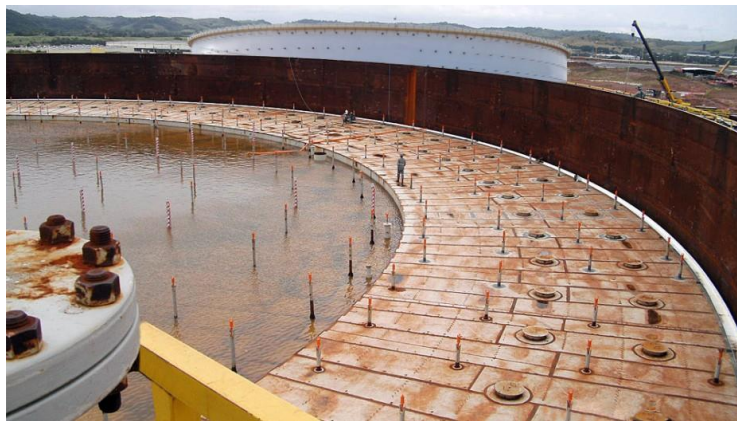
Figura 4 – Modelo de tanque com teto flutuante
