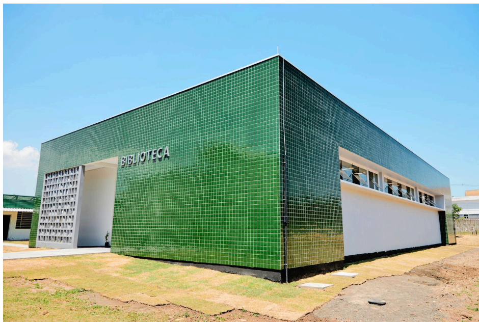
Figura 3: Biblioteca do Campus Restinga (2026)
