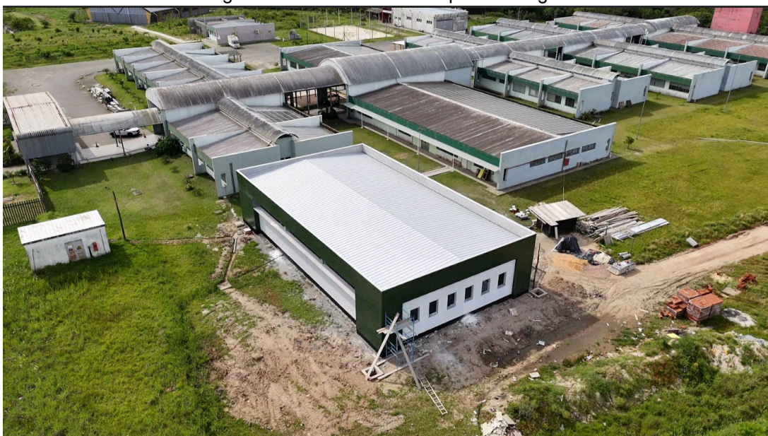
Figura 2: Foto aérea do Campus Restinga
