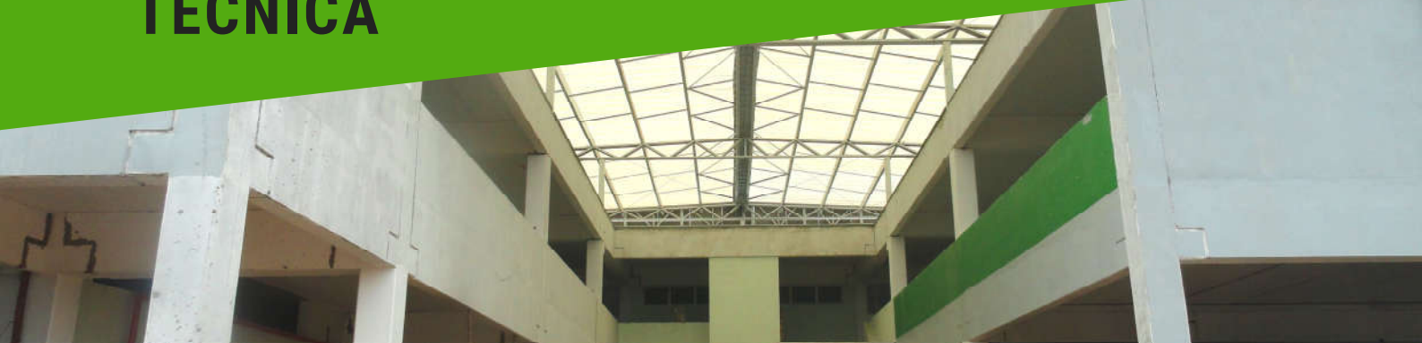
Construção do Bloco Administrativo Campus Vacaria do IFRS, 2014
