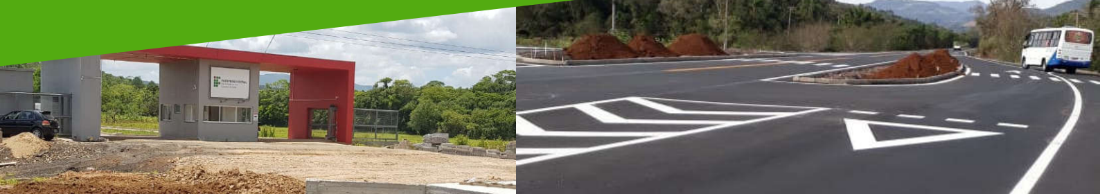
Construção do Acesso Campus Rolante do IFRS, 2018
