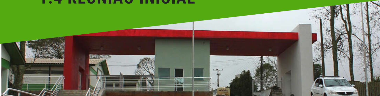
Construção do Pórtico Campus Ibirubá do IFRS, 2016
