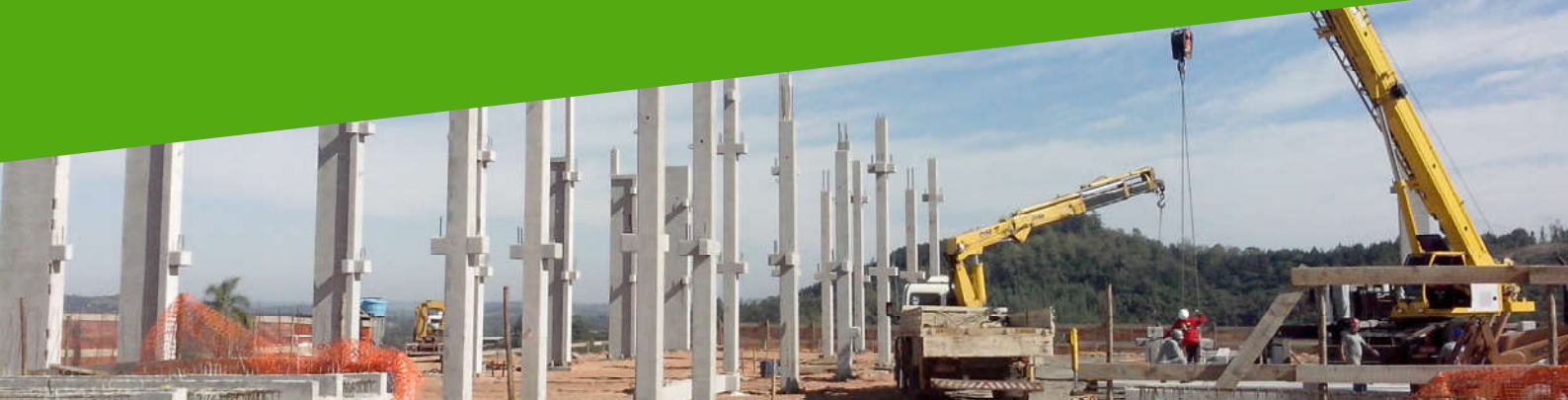
Construção do Bloco Administrativo Campus Rolante do IFRS, 2014
