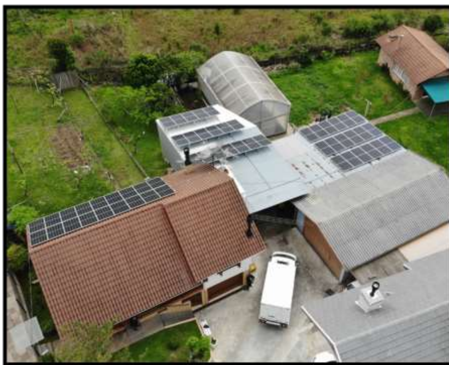
Figura 1: Detalhe telhado de placas solares da agroindústria analisada Carlos Barbosa. Fonte: Acervo pessoal de Afonso Dalmas.
