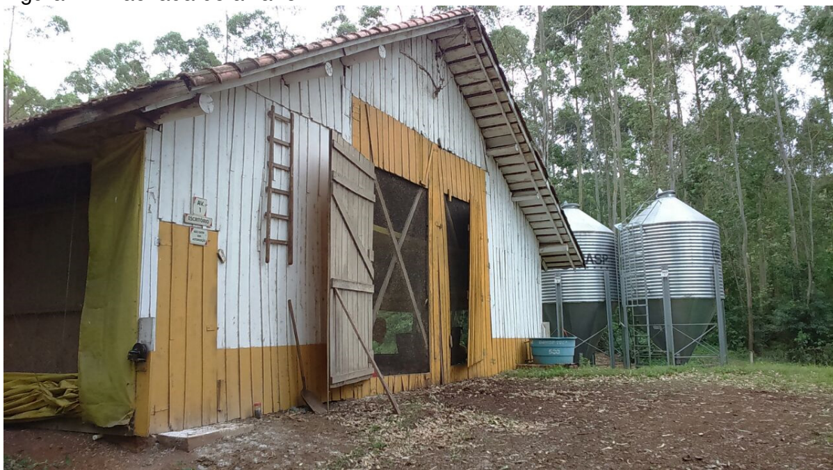
Figura 2 – Fachada do aviário.
