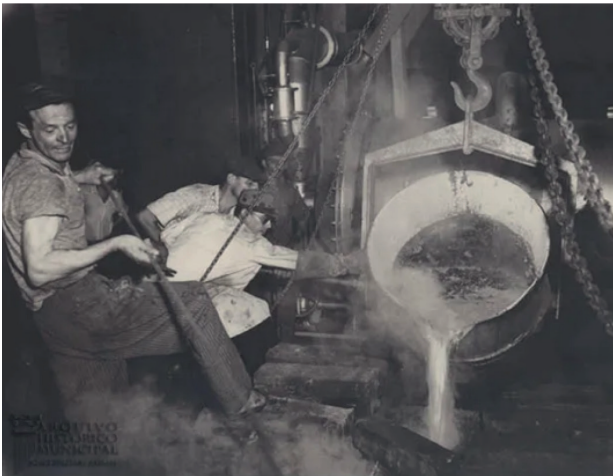
Fundição da Metalúrgica Abramo Eberle S.A. (1957)
