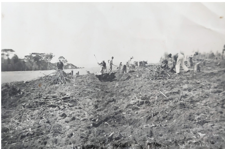
Figura 11. Trabalhos de destocamento na área da EEPF em Vila Englert. Fonte: Arquivo pessoal de Quintino Corrêa dos Santos.
